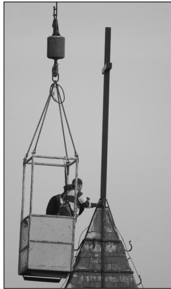
Twee monteurs van bedrijf Van der Heide maken beide bliksemafleidingen weer vast aan het kruis.
